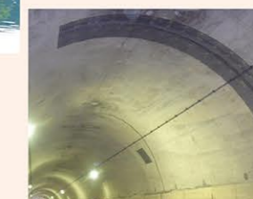
トンネル壁面の補修
