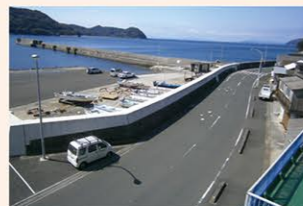
三崎港海岸(伊方町)
