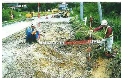
写真③：応急復旧工事で舗装を撤去後の状況
