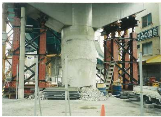
当て板補修工、変形修正工、代替部材設置工（鋼板・ボルト等）
