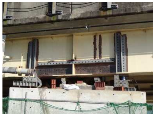
当て板補修工、変形修正工、代替部材設置工（鋼板・ボルト等）
