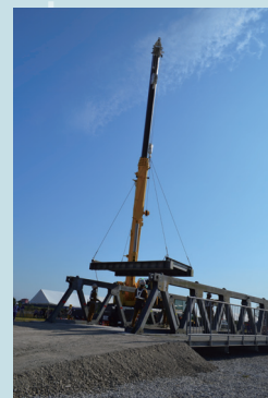
【応急組立橋設置】
