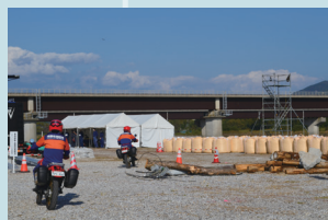
【車両による被災状況調査】
