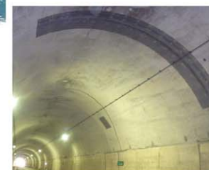
トンネル壁面の補修
