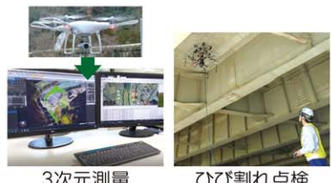
3次元測量 ひび割れ点検 UAVの活用
