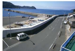
三崎港海岸(伊方町)
