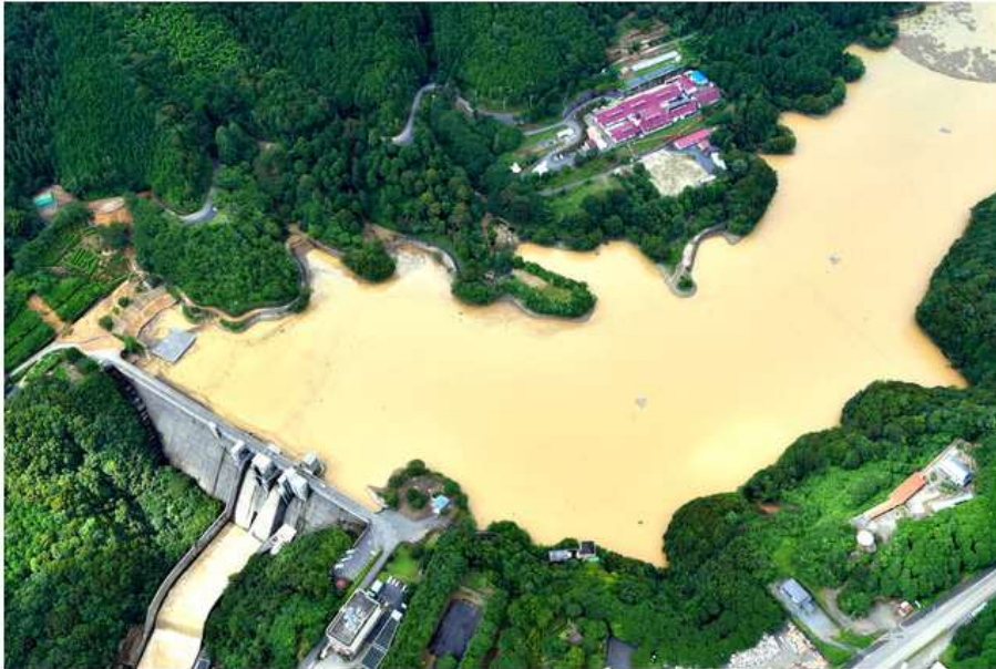
大雨時に放水された野村ダム。流れは市街地に続いている＝2018年7月9日、愛媛県西予市野村町、朝日新聞社ヘリから、日吉健吾撮影
