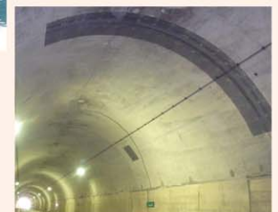
トンネル壁面の補修
