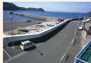
三崎港海岸(伊方町)
