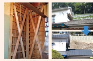
耐震改修(筋かい追加) 耐風改修(瓦屋根の葺き替え)
