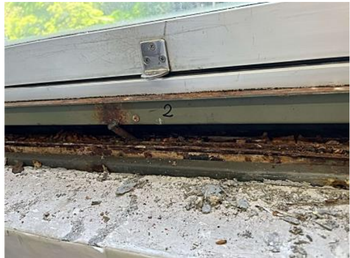
(4階北面執務室)
