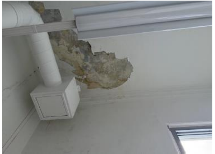
(本館・議事堂4階渡り廊下天井)
