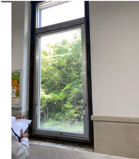
(4階北面執務室)
