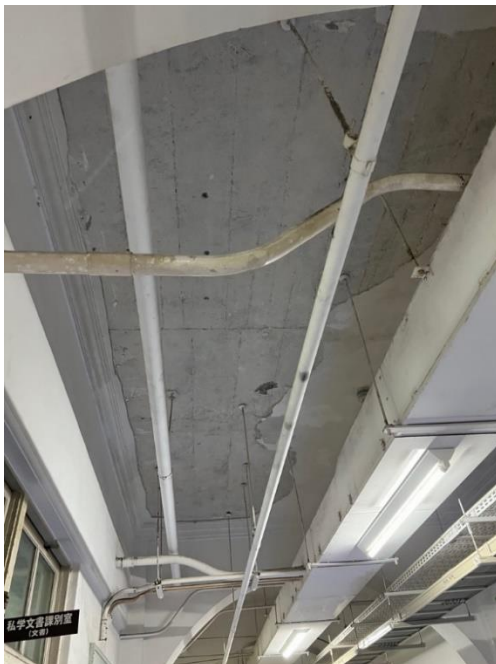
浮き部分を全て除去
