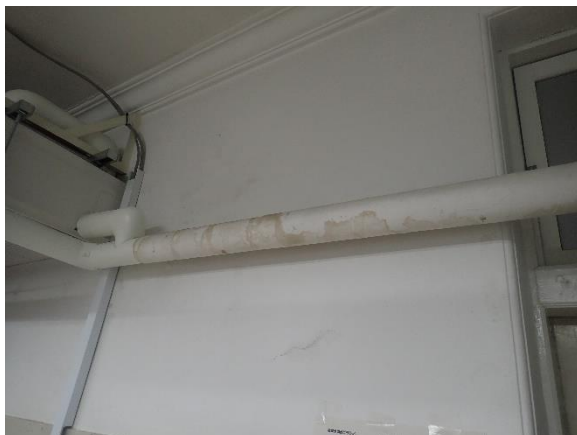
(1階西側執務室内)
