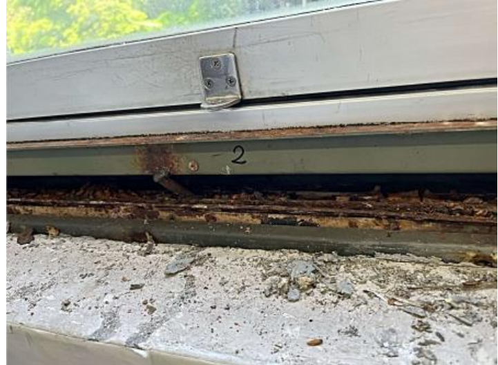
(4階北面執務室)
