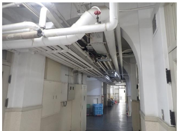
(1階西側廊下天井)
