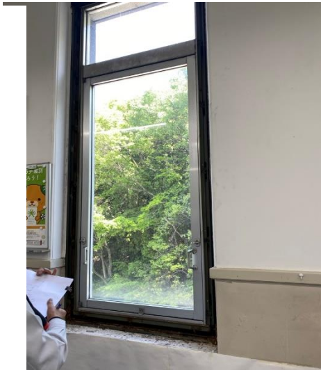
(4階北面執務室)
