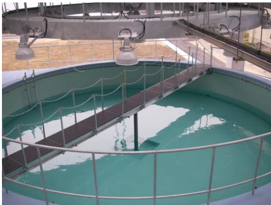
100 トン円形コンクリート水槽
