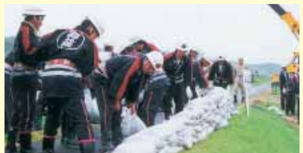
▲水害に備えてチームワークよく土のうを設置
