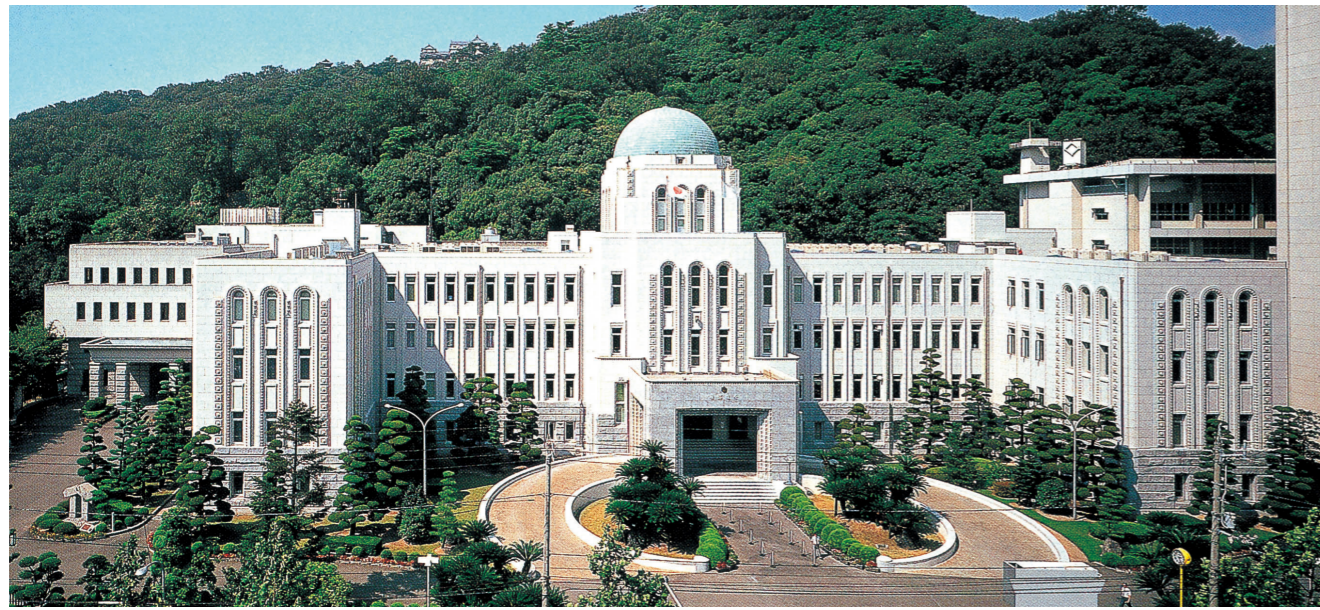
愛媛県庁本館(昭和4年(1929年)2月竣工)
