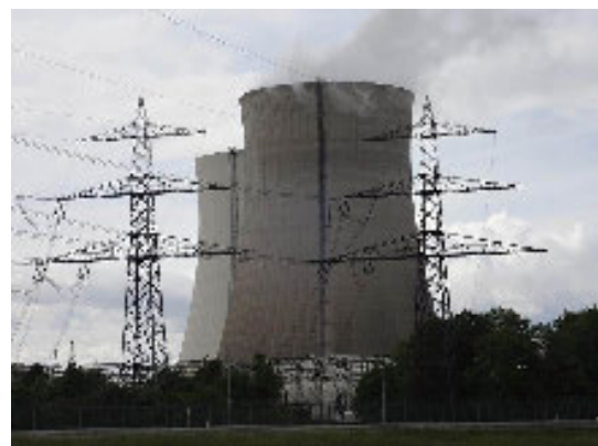
フィリップスブルグ原子力発電所
