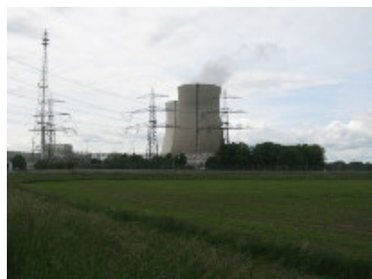
フィリップスブルグ原子力発電所
