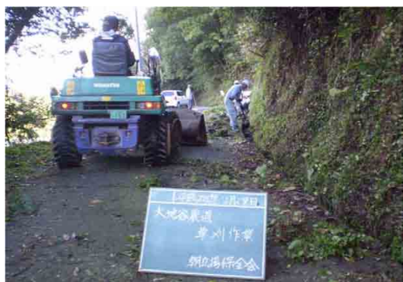
【水路清掃・草刈り作業】
