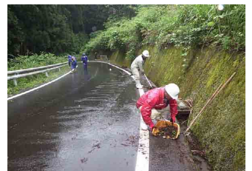
【水路清掃・草刈り作業】
