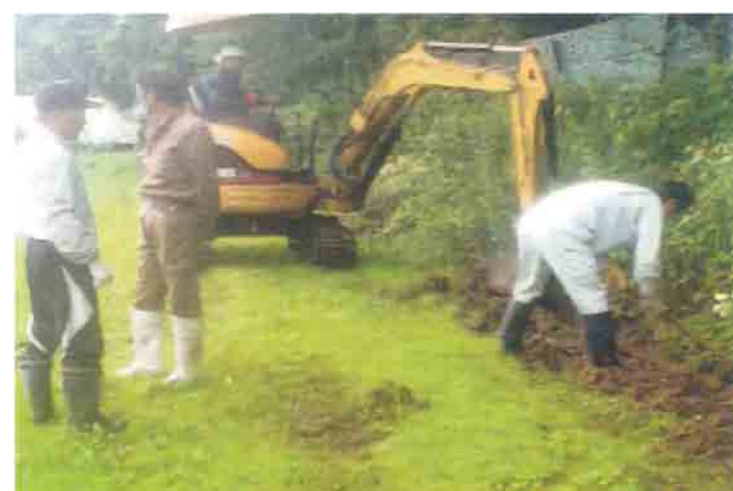
【重機を使った水路清掃】
