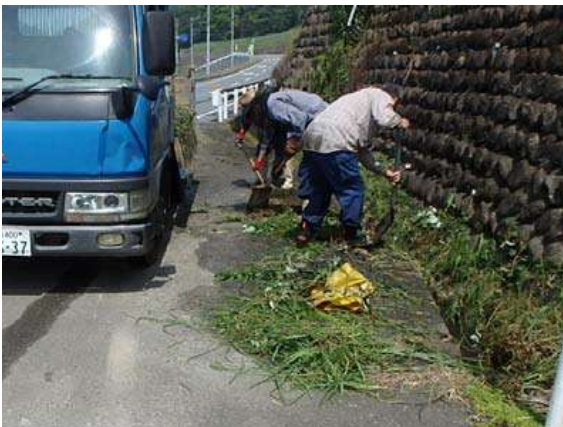
平成27年5月 用水路清掃
