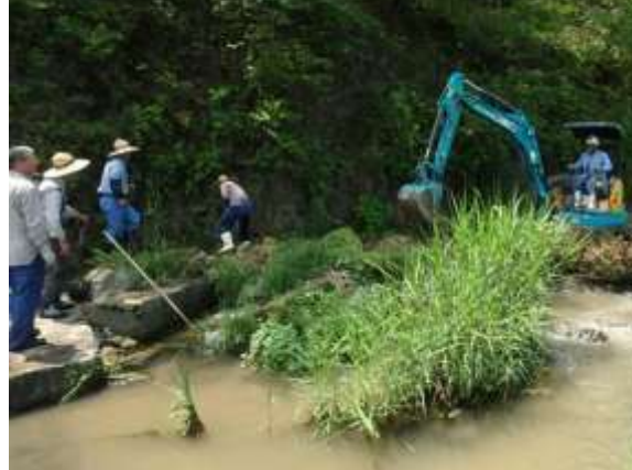
平成27年5月 堰上げ
