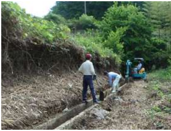
平成27年5月 用水路清掃
