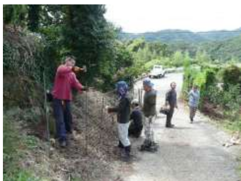
【防護柵設置の様子】
