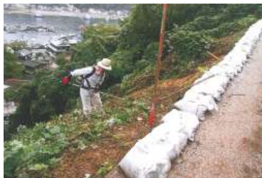
【被災した農道の応急修理】
