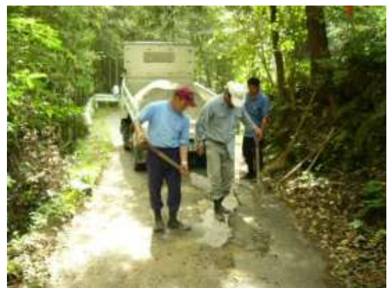
【農道の補修状況】
