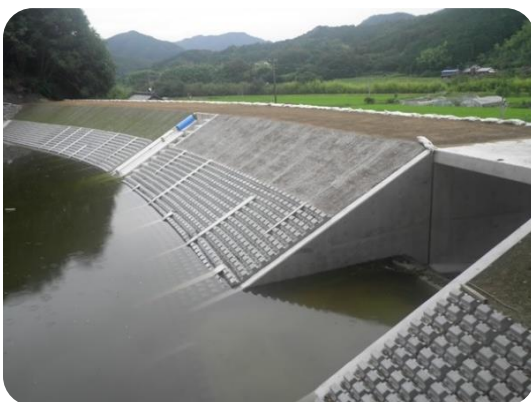
堤体を改修したため池（松野町）
