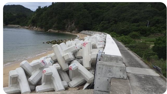
堤防の嵩上げ (上島町：佐島東地区)
