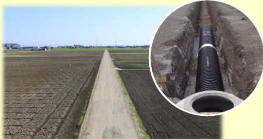
道路に埋設した排水管で降雨を排水
