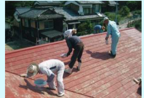
集会所の屋根の改修
