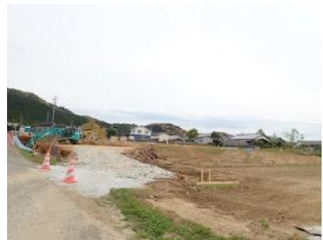
整備中のハウス建設予定地
