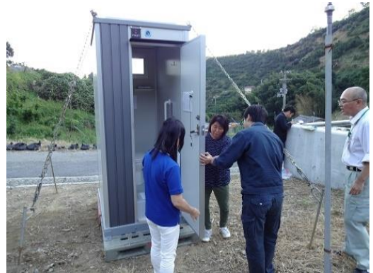
簡易水洗トイレの設置
