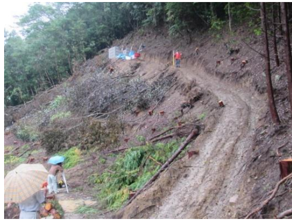
山頂貯水槽の施工
