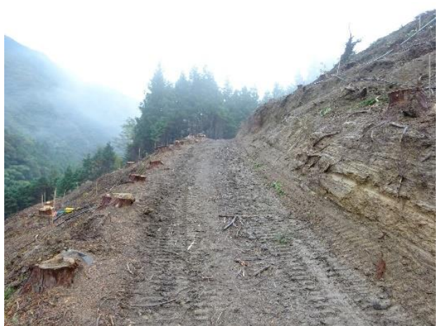
新たに整備した園内作業道
