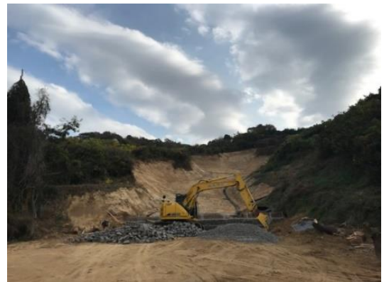
復旧が進む被災園地（高浜地区）
