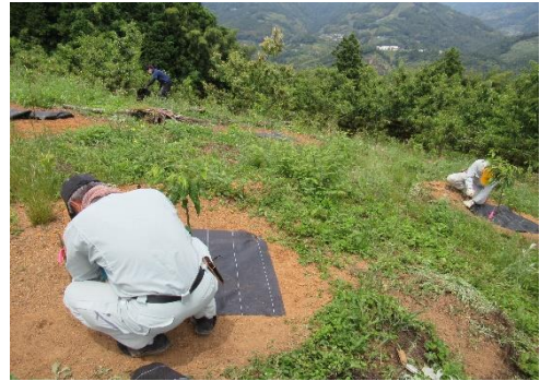
防草シート設置作業
