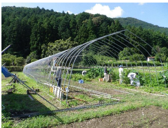
空きハウス解体作業中
