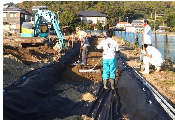
排水用パイプ（左）と防根シート（右）の設置
