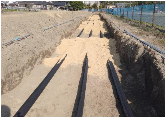
排水用パイプ（左）と防根シート（右）の設置
