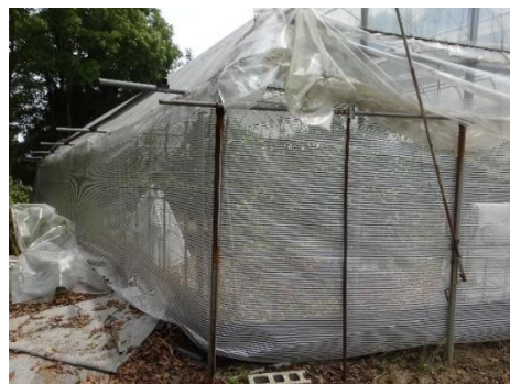
光反射シートを展張した施設
