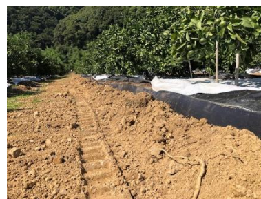
掘削土を溝に戻す
