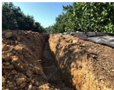
バックホーで掘削
