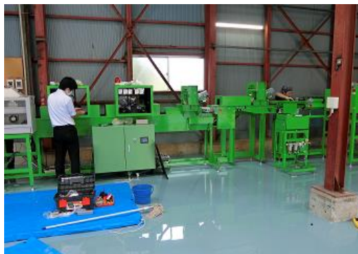
A I 選果機を移転設置した拠点
