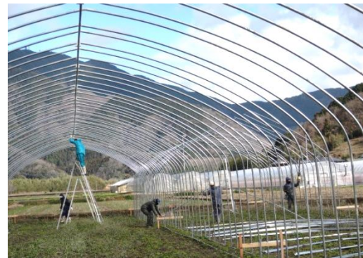
高張力鋼管を利用したしょうが栽培ハウス (大洲市)
