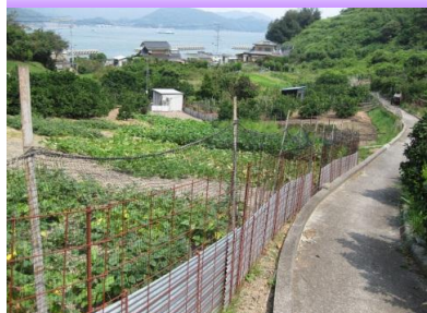
防除柵の設置状況の確認
