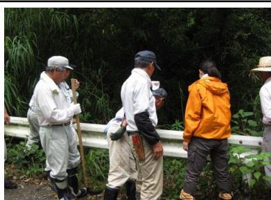
住民による集落内の点検活動
