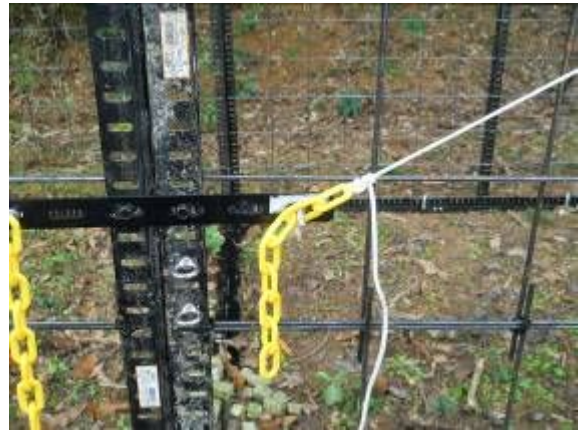
写真 11-4 プラスチックチェーンによる仮止め
