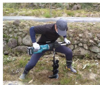
図2 縦穴をあけ排水性改善
