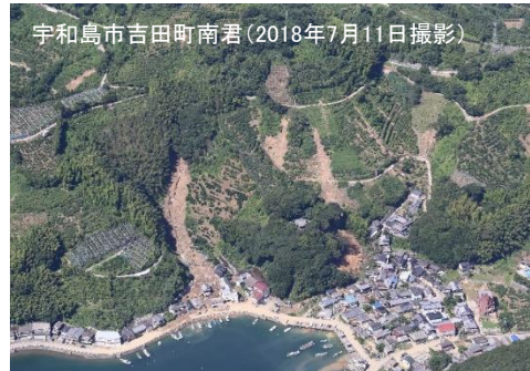
平成30年7月の西日本豪雨で発生した土砂災害
