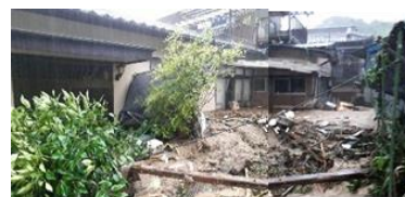
高浜5丁目の住宅被災状況
