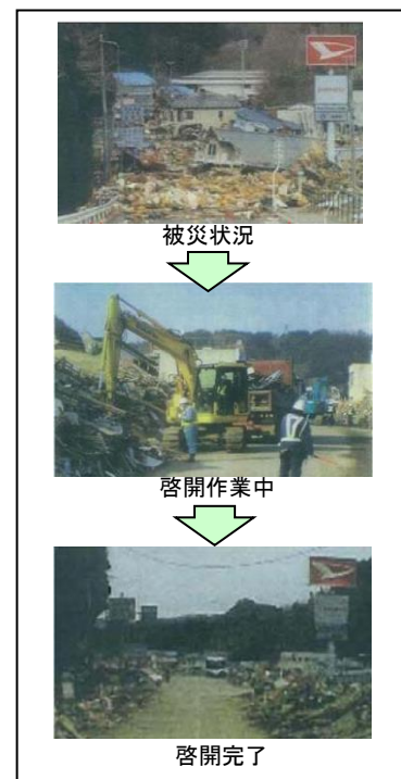
写真1 道路啓開作業の例 (日本橋梁建設協会セミナー資料 H24.7.25 四国地方整備局より)
