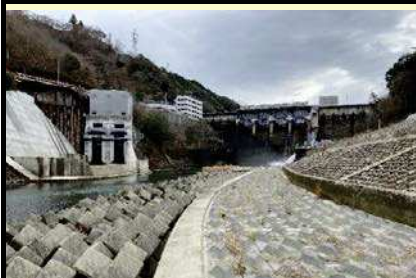
スタート地点：鹿野川ダム直下
