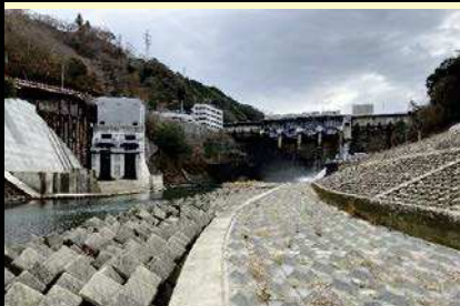
スタート地点：鹿野川ダム直下
