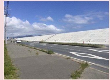
海岸堤防の整備
