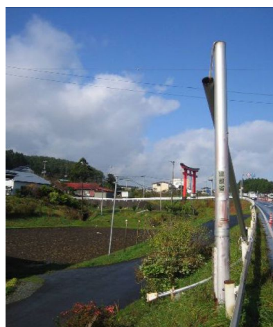
写真 - 解 3 . 3 支柱溶接部の腐食による倒壊事例
