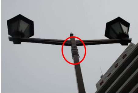
写真-解3.1 デザイン式道路照明柱
