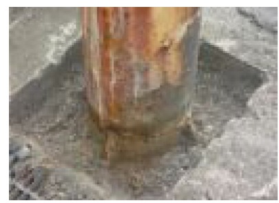
コンクリートを掘削
