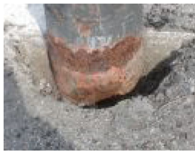
アスファルトを掘削
