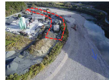
肱川（追打下流工区）
