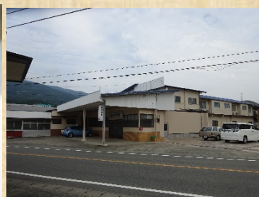
復旧後のふるさと旅館
