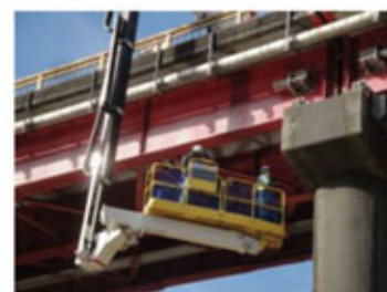
【橋梁点検車による定期点検】
