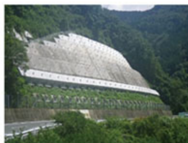
法面防災対策(アンカー工)
