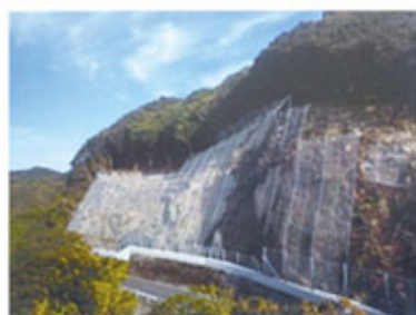
法面防災対策(落石防護工)
