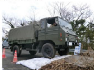
段差すりつけ (土のう使用)
