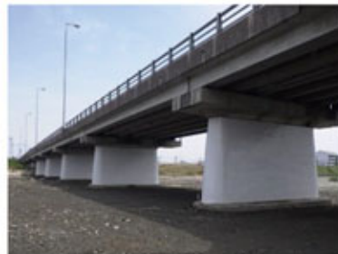
橋梁耐震対策(橋脚巻立工)
