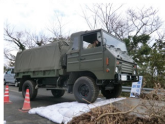
段差すりつけ (土のう使用)
