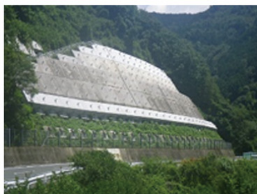
法面防災対策(アンカー工)
