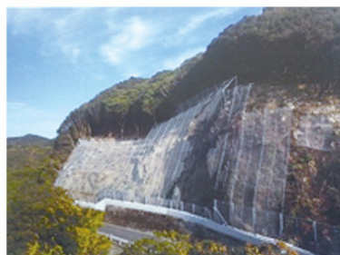
法面防災対策(落石防護工)
