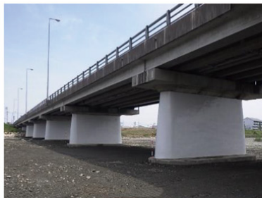
橋梁耐震対策(橋脚巻立工)
