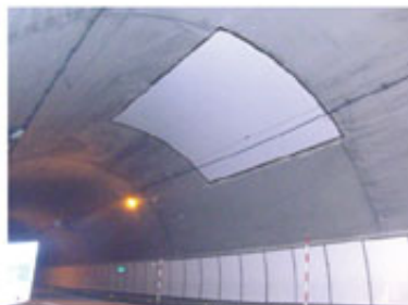
トンネル保全対策 (炭素繊維シート補強工)
