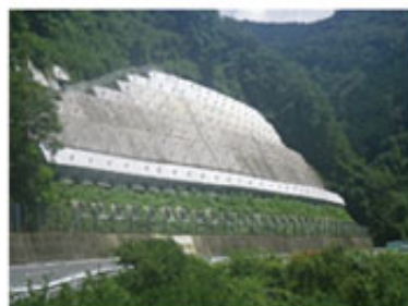
法面防災対策(アンカー工)
