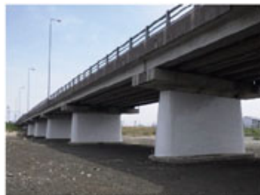
橋梁耐震対策(橋脚巻立工)
