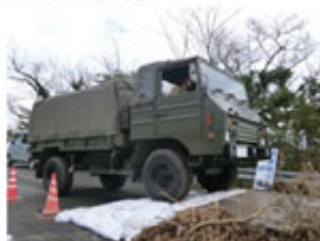
段差すりつけ (土のう使用)
