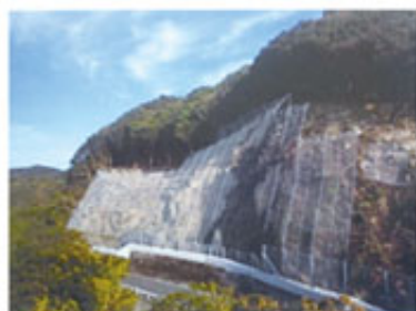
法面防災対策(落石防護工)
