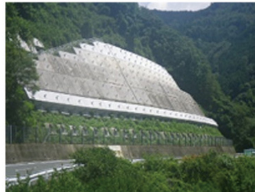
法面防災対策(アンカー工)
