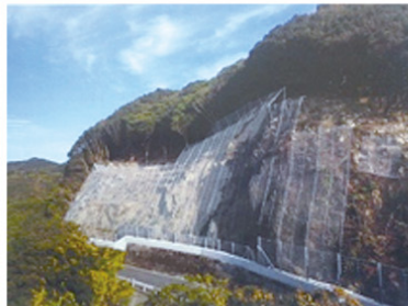
法面防災対策(落石防護工)
