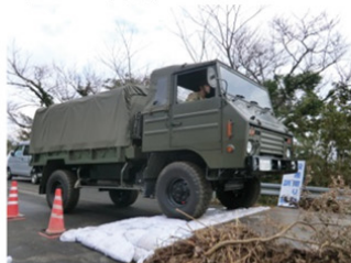
段差すりつけ (土のう使用)
