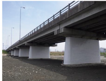
橋梁耐震対策(橋脚巻立工)
