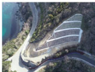
法面防災対策(法枠工)
