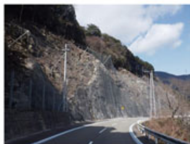
法面防災対策(ロックネット工)
