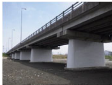
橋梁耐震対策(橋脚巻立工)
