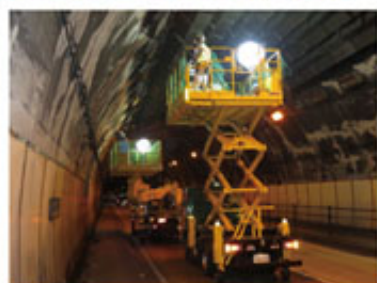
トンネル点検状況
