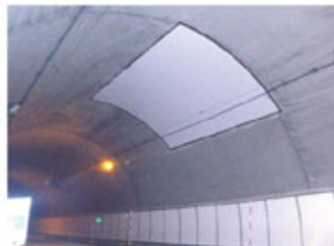
トンネル保全対策
