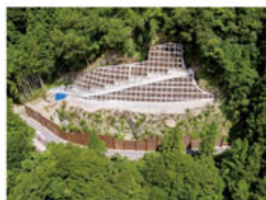
法面防災対策
