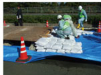
【段差すりつけ】
