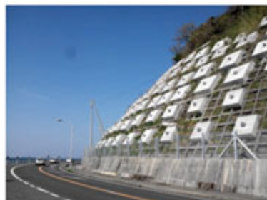
法面防災対策
