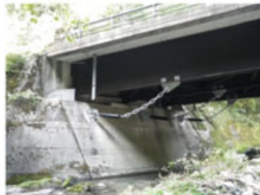
橋梁耐震対策
