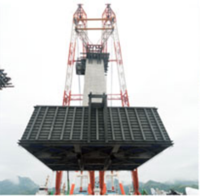
国内最大の起重機船による橋脚「ベルタイプ基礎」の運付
