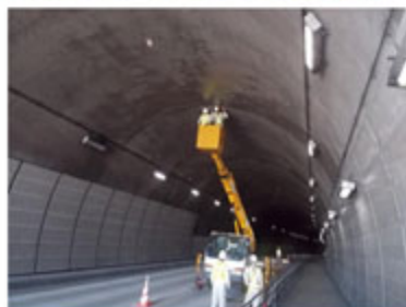
トンネル点検状況
