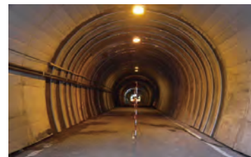
漏水対策工
