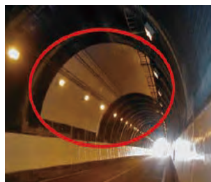
剥落防止工 (炭素繊維シート貼付け)
