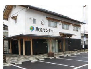
道の駅内にある防災センター
