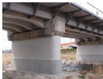
橋脚補強 (コンクリート巻立)
