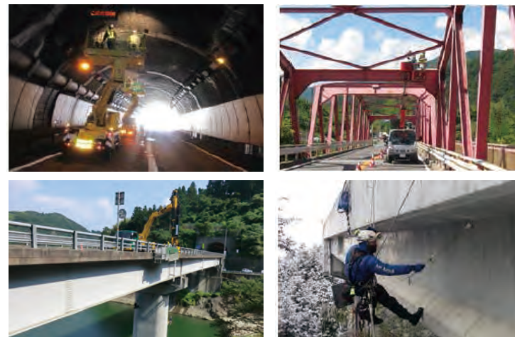
【点検・診断状況】
