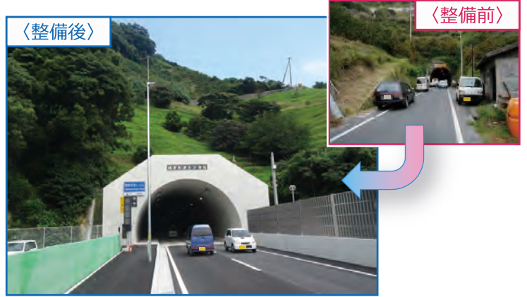
(国) 378号 俵津バイパス (俵津玉津トンネル 平成26年7月12日開通)
