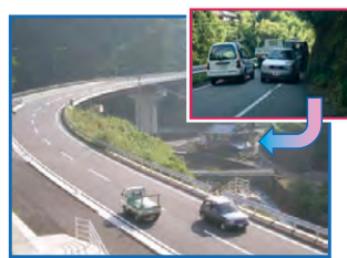
【(国) 379号 岩谷バイパス 新千里口橋付近】
