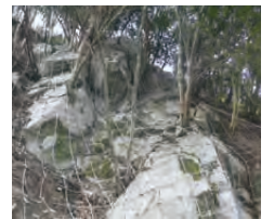
落石防止工(ワイヤーロープ掛け工)
