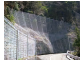
落石防止工(落石防護網)
