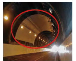
剥落防止工 (炭素繊維シート貼付け)
