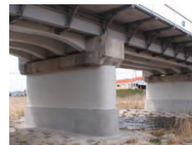
橋脚補強 (コンクリート巻立)
